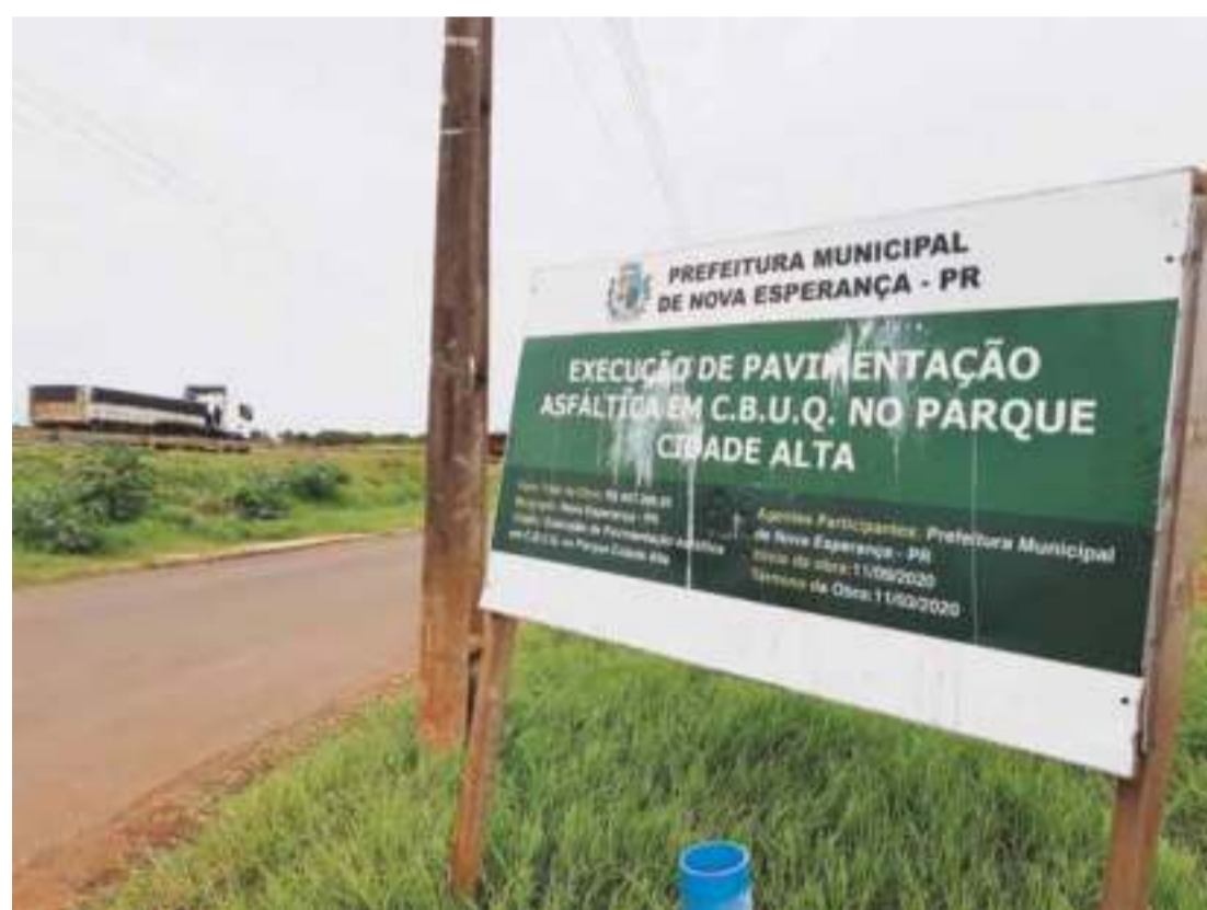
Parque Cidade Alta - Pavimentação asfáltica
