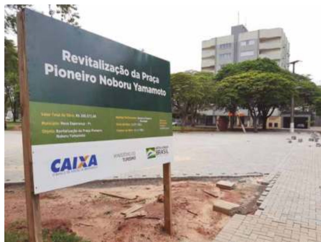
Obras de infraestrutura na região central da cidade: revitalização da Praça Pioneiro Noboru Yamamoto
